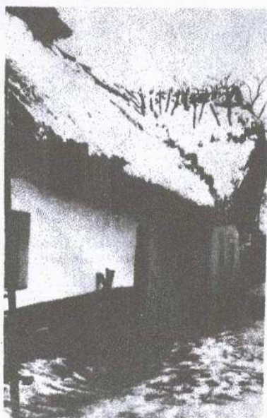
I-1. ábra, A Fő ut 2/ a számú lakóház udvar feléli homlokzata.
